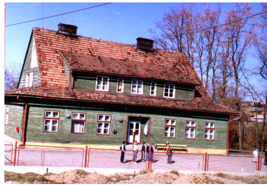
Budynek drewniany 1997r. - kronika szkoły
