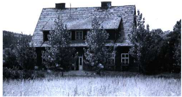
Budynek drewniany 1971r. - kronika szkoły
